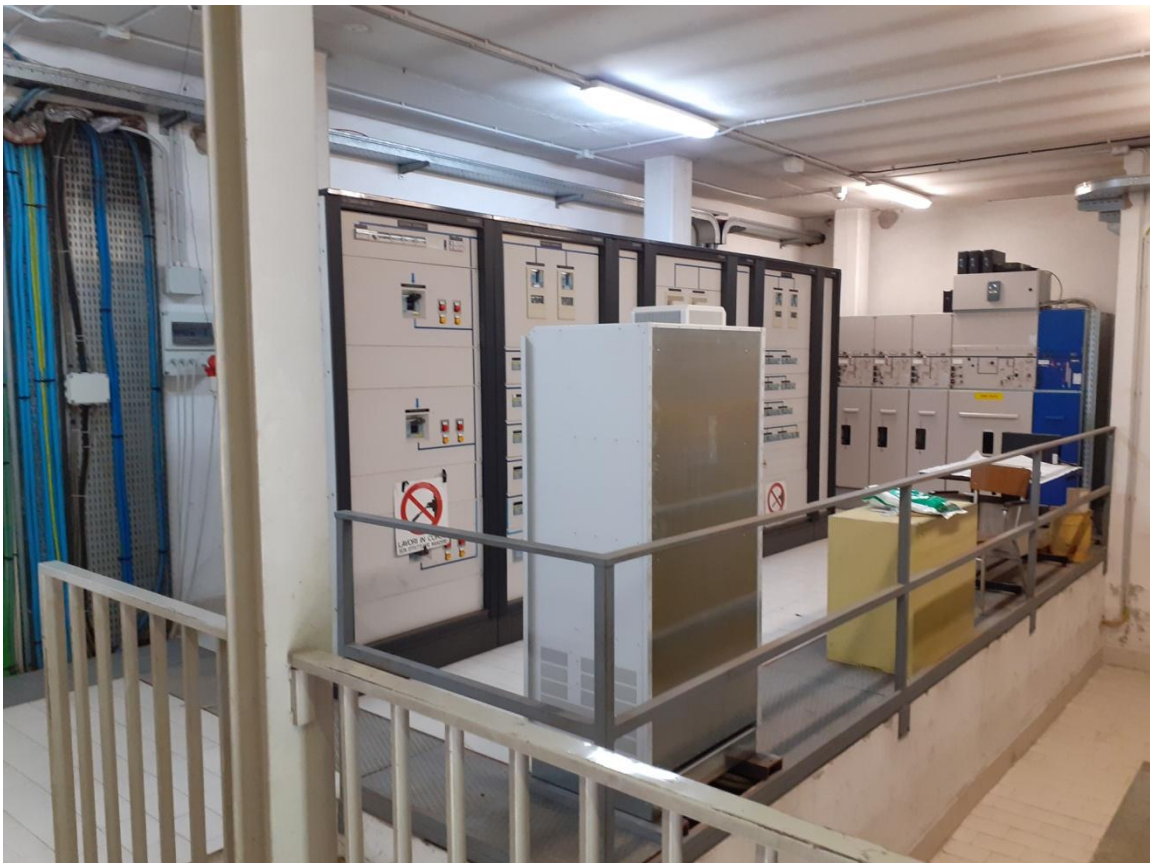
Foto 43 Cabina elettrica di trasformazione
