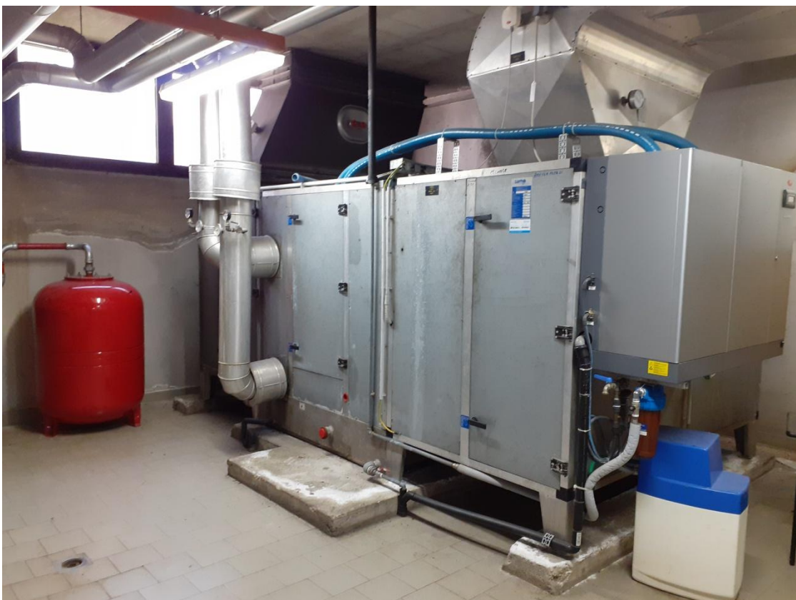
Foto 20 Piano seminterrato – locale tecnico – termoventilazione Residenza Mimose
