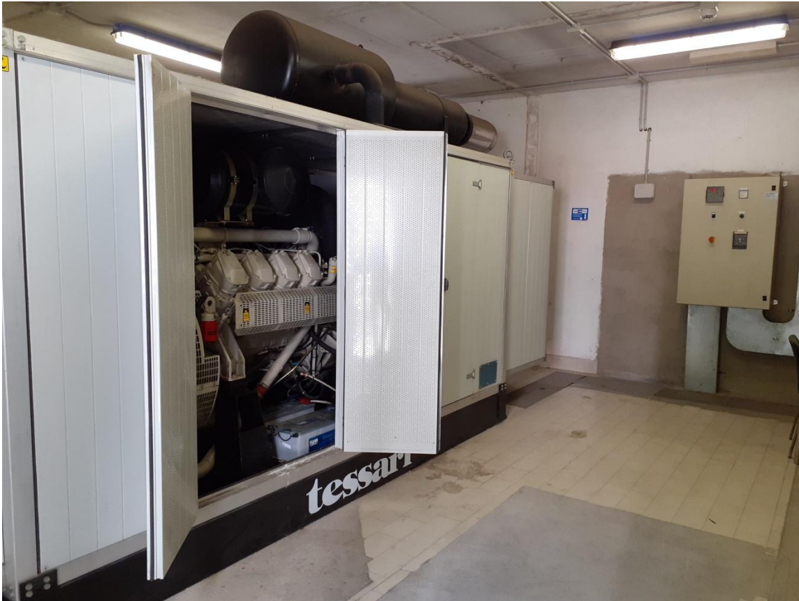
Foto 42 Locale gruppo elettrogeno
