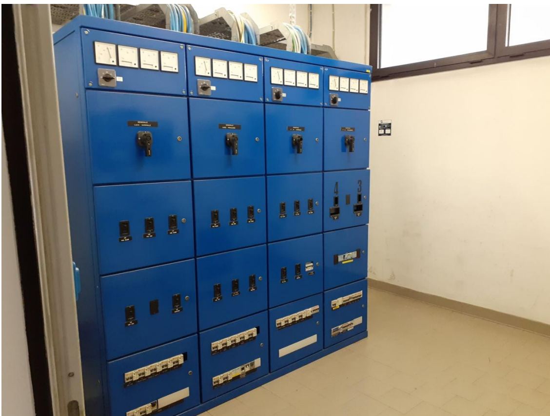
Foto 25 Piano seminterrato - locale tecnico (quadri elettrici)
