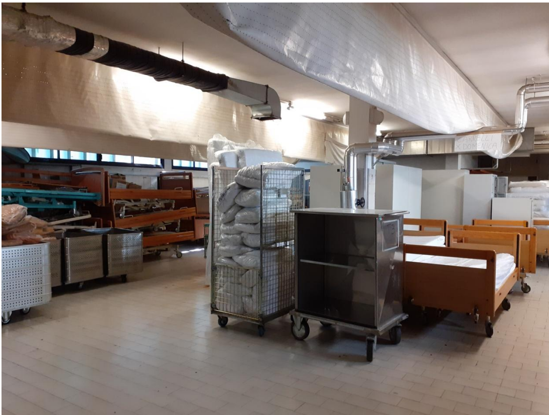
Foto 12 Piano seminterrato – deposito (ex lavanderia)
