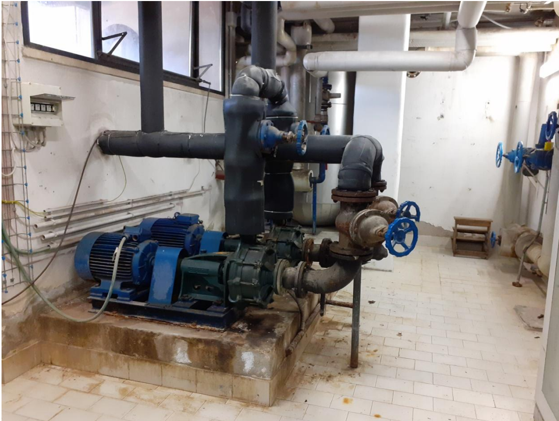
Foto 09 Piano seminterrato – locale tecnico – centrale idrica
