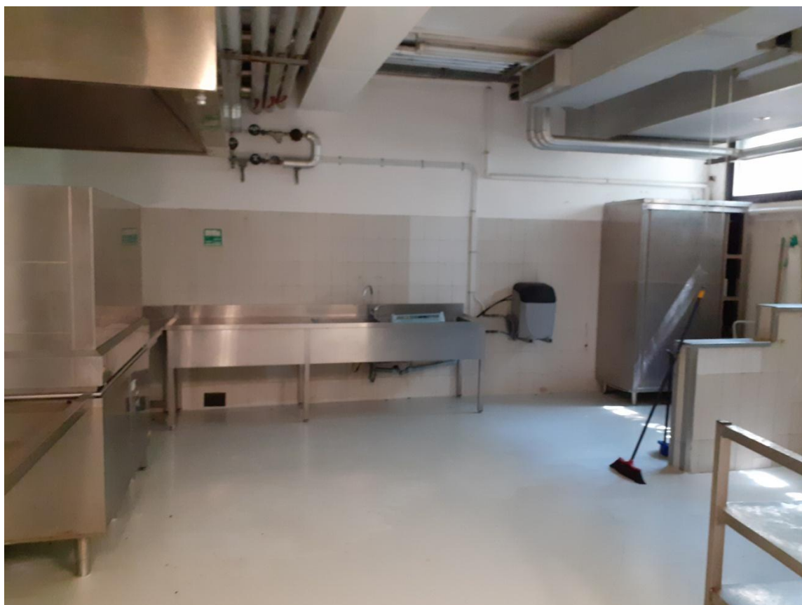
Foto 30 Piano seminterrato – centro cottura – zona lavaggio stoviglie
