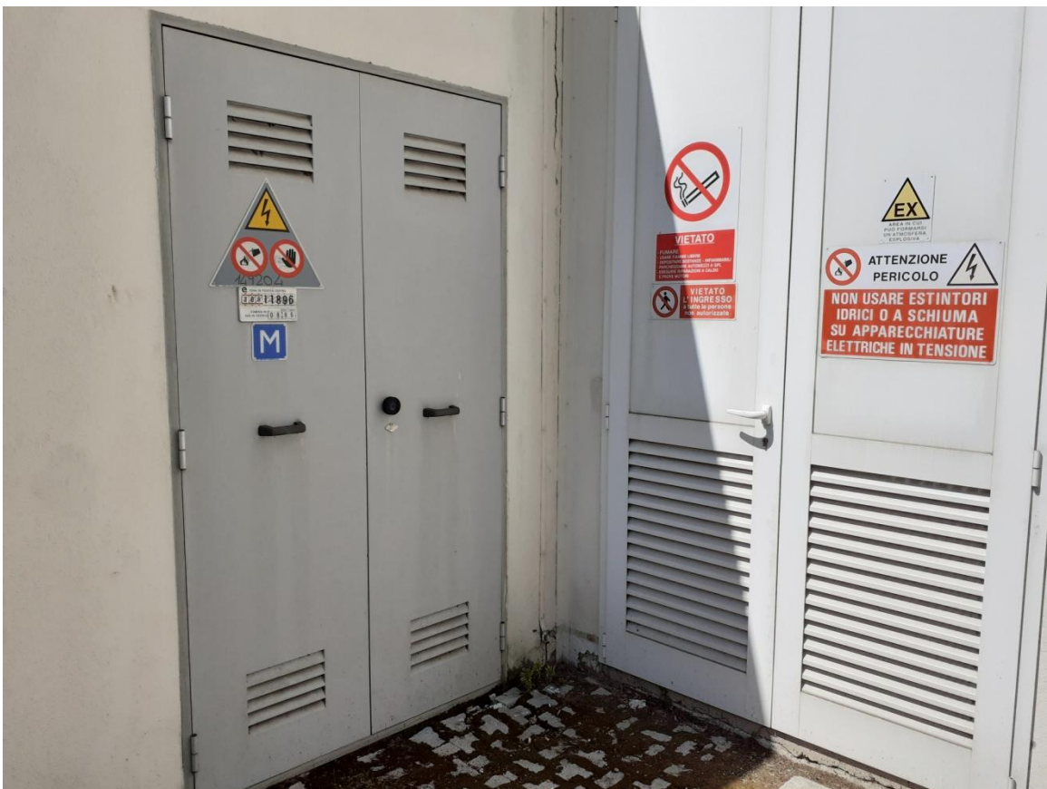
Foto 45 Accessi locali tecnici (punto consegna ENEL)
