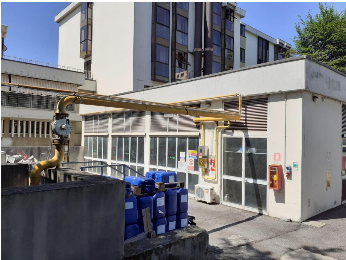
Foto 41 Vista centrale termica
