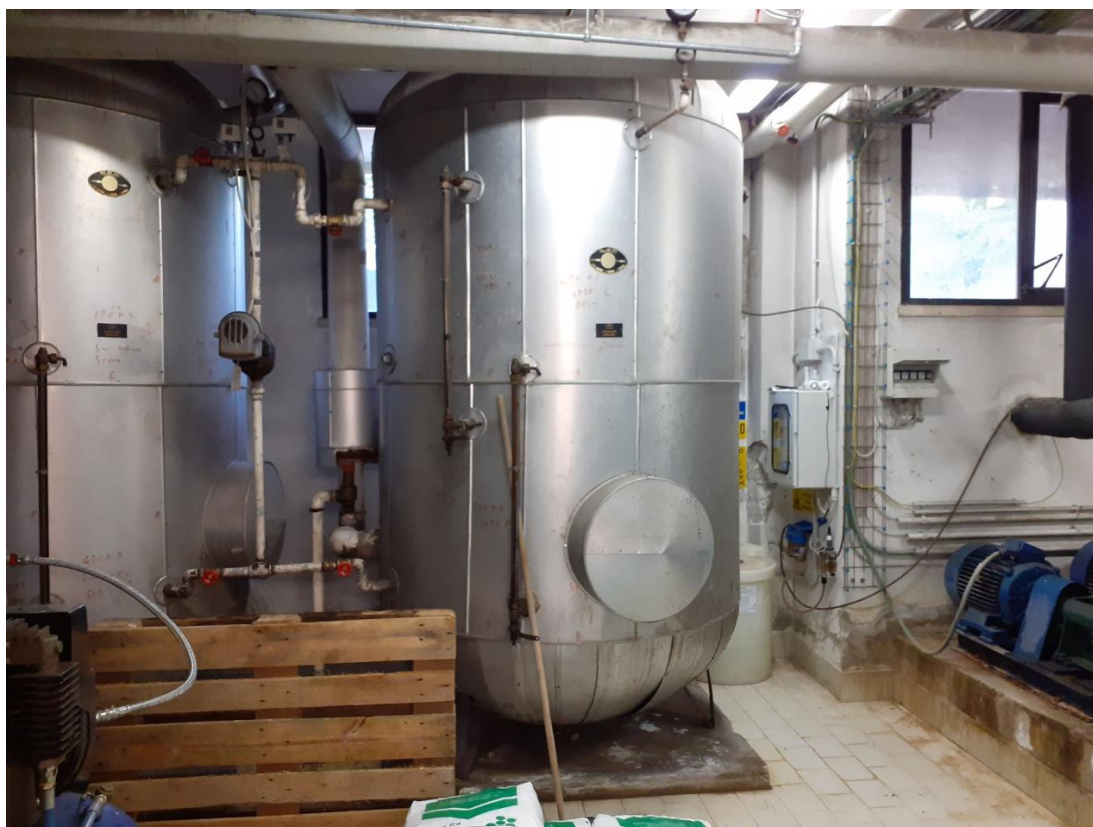
Foto 08 Piano seminterrato - locale tecnico - centrale idrica
