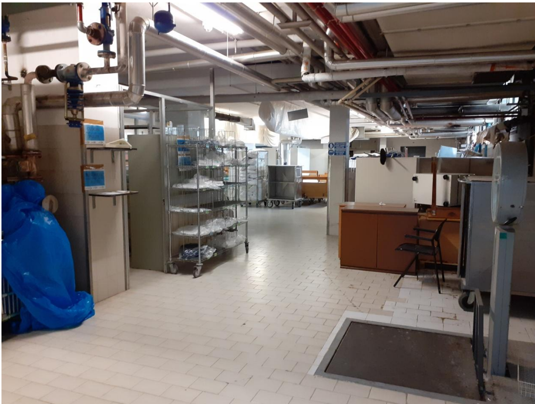
Foto 10 Piano seminterrato – deposito (ex lavanderia)
