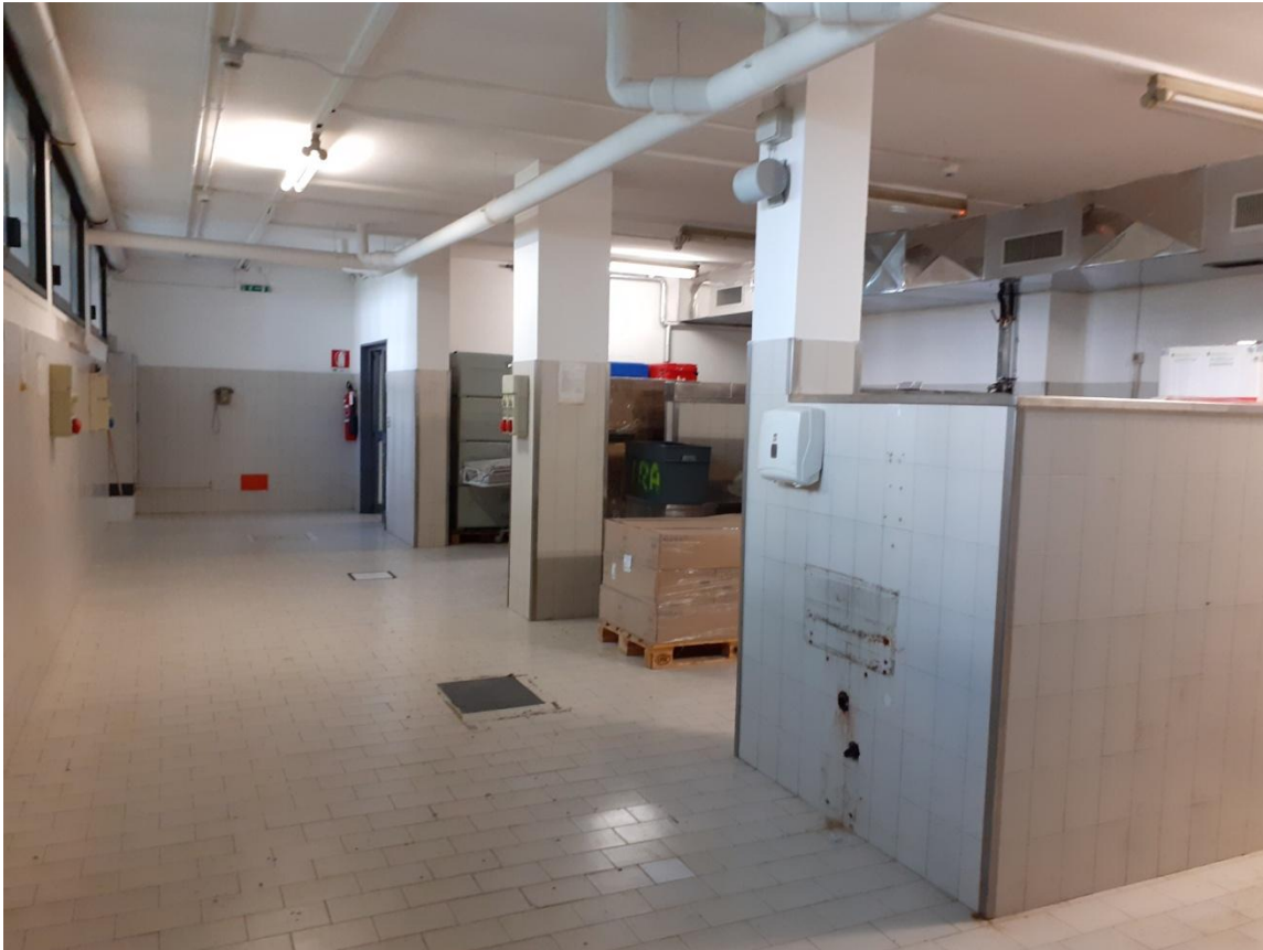
Foto 32 Piano seminterrato – ex centro cottura – preparazione
