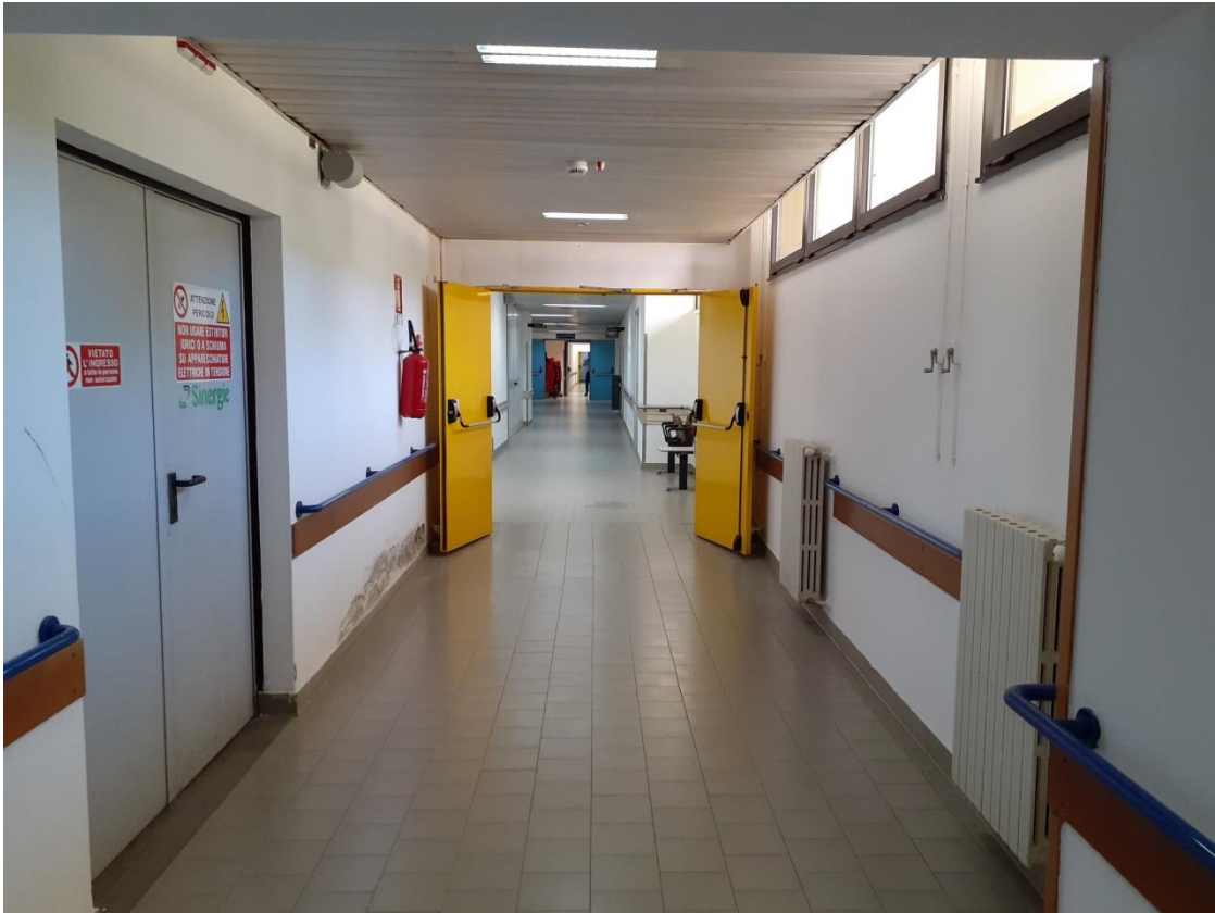
Foto 19 Piano seminterrato – collegamento
