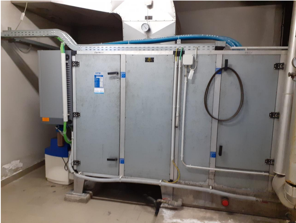
Foto 23 Piano seminterrato – locale tecnico - termoventilazione Residenza Fiordalisi
