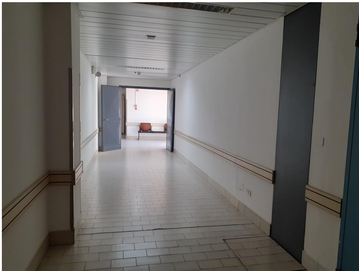
Foto 46 Piano seminterrato - collegamento
