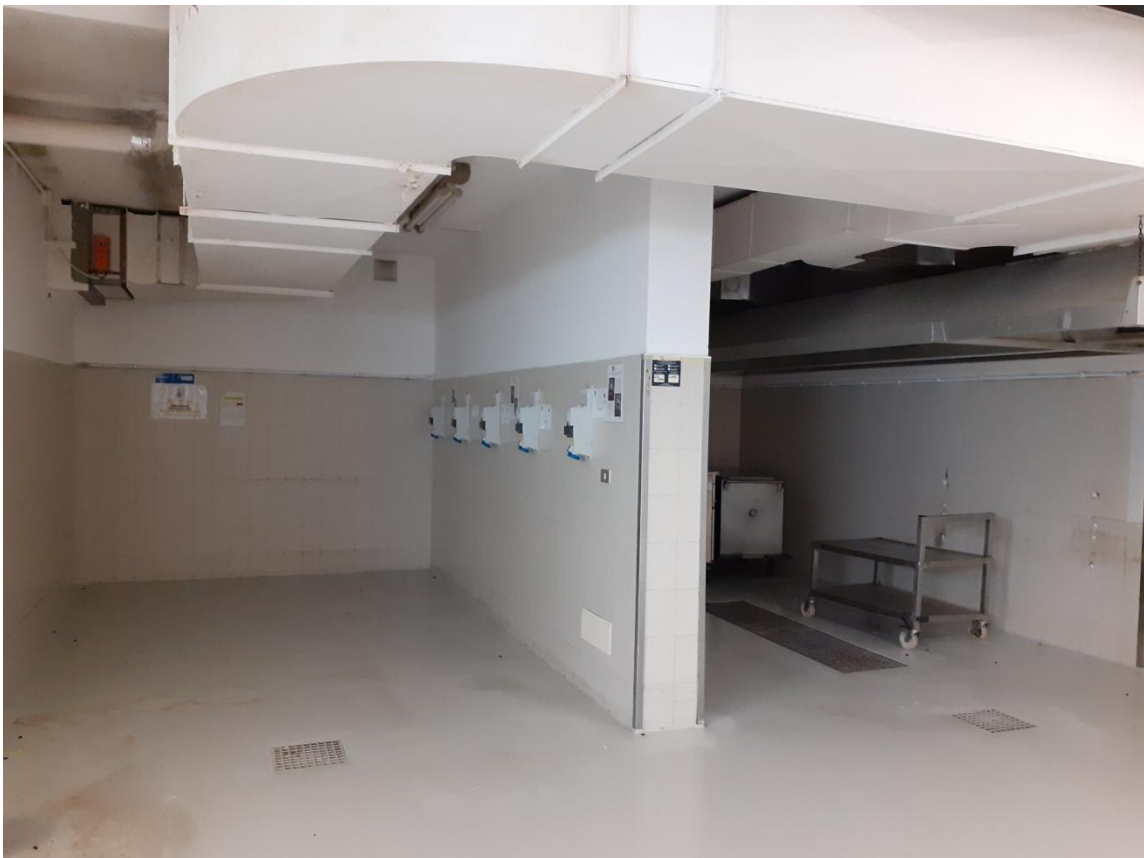
Foto 29 Piano seminterrato – ex centro cottura – zona distribuzione
