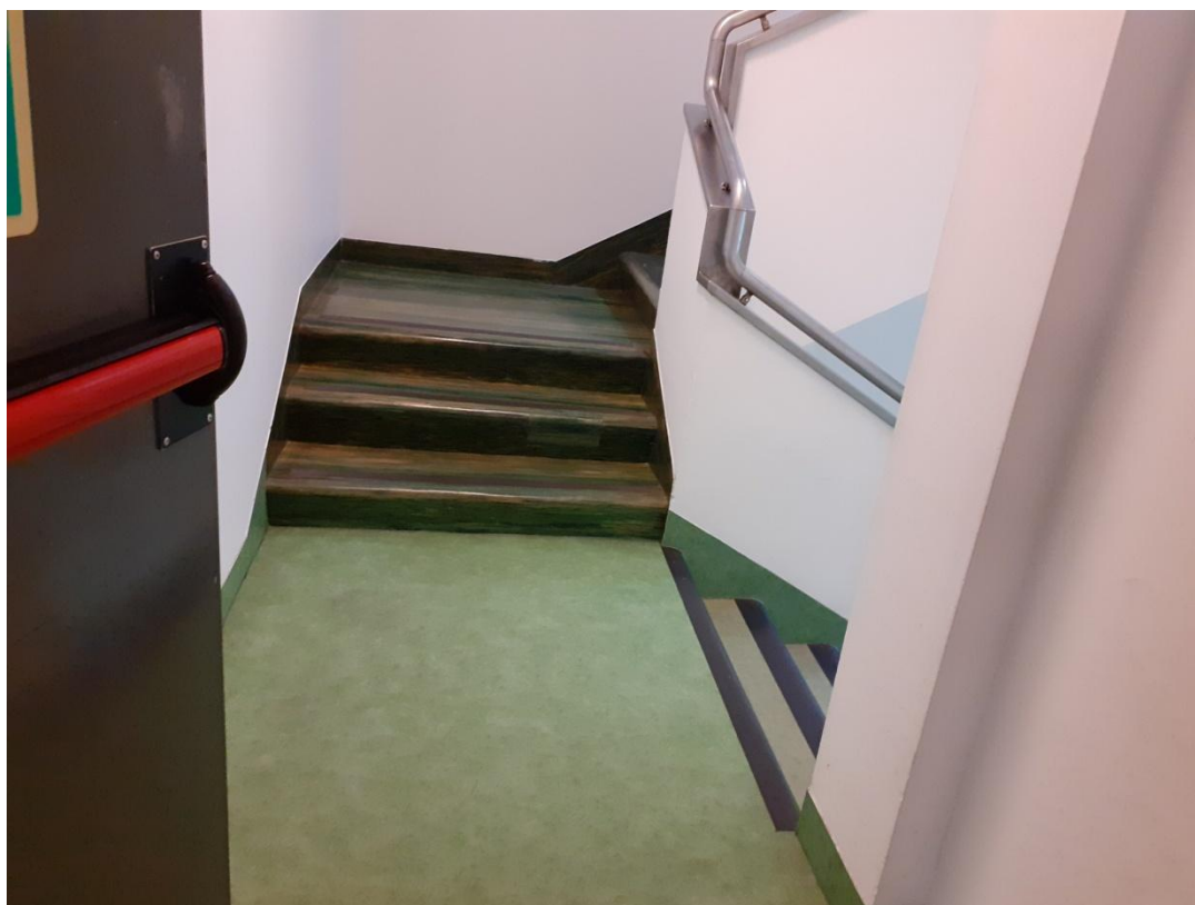
Foto 05 Corpo scale – collegamento al piano seminterrato
