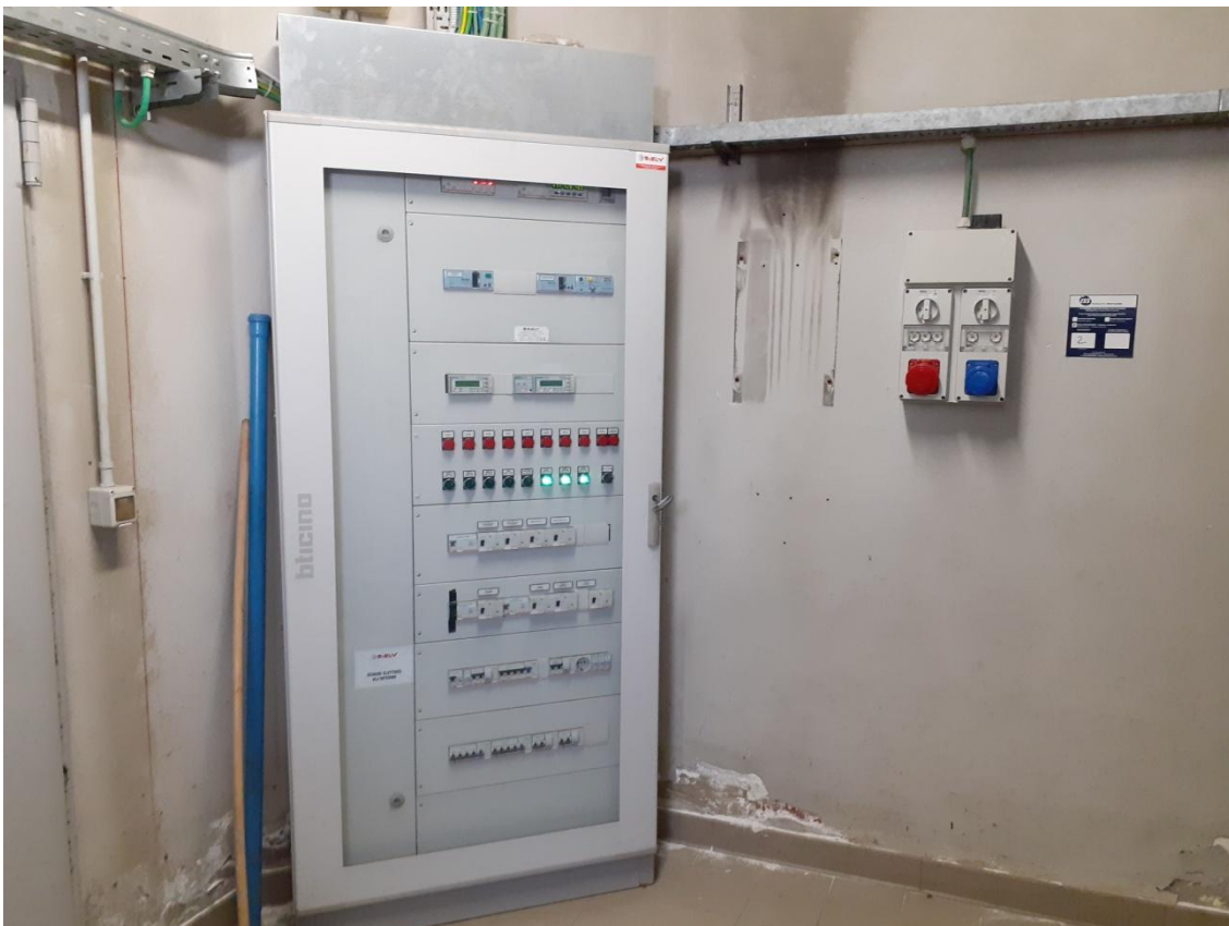
Foto 23-bis Piano seminterrato – locale tecnico - termoventilazione Residenza Fiordalisi (quadro elettrico tipo a servizio UTA)
