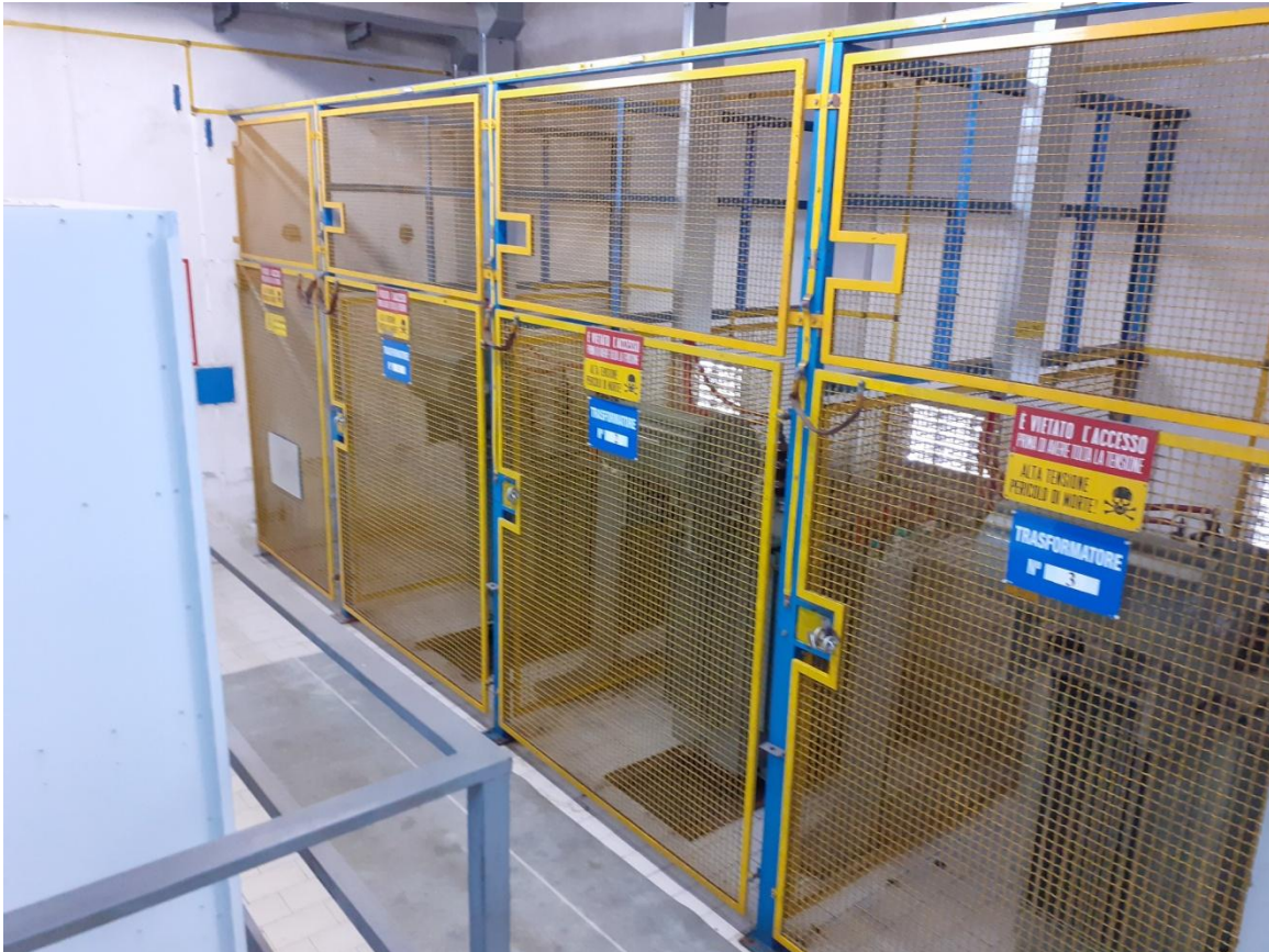
Foto 44 Cabina elettrica di trasformazione
