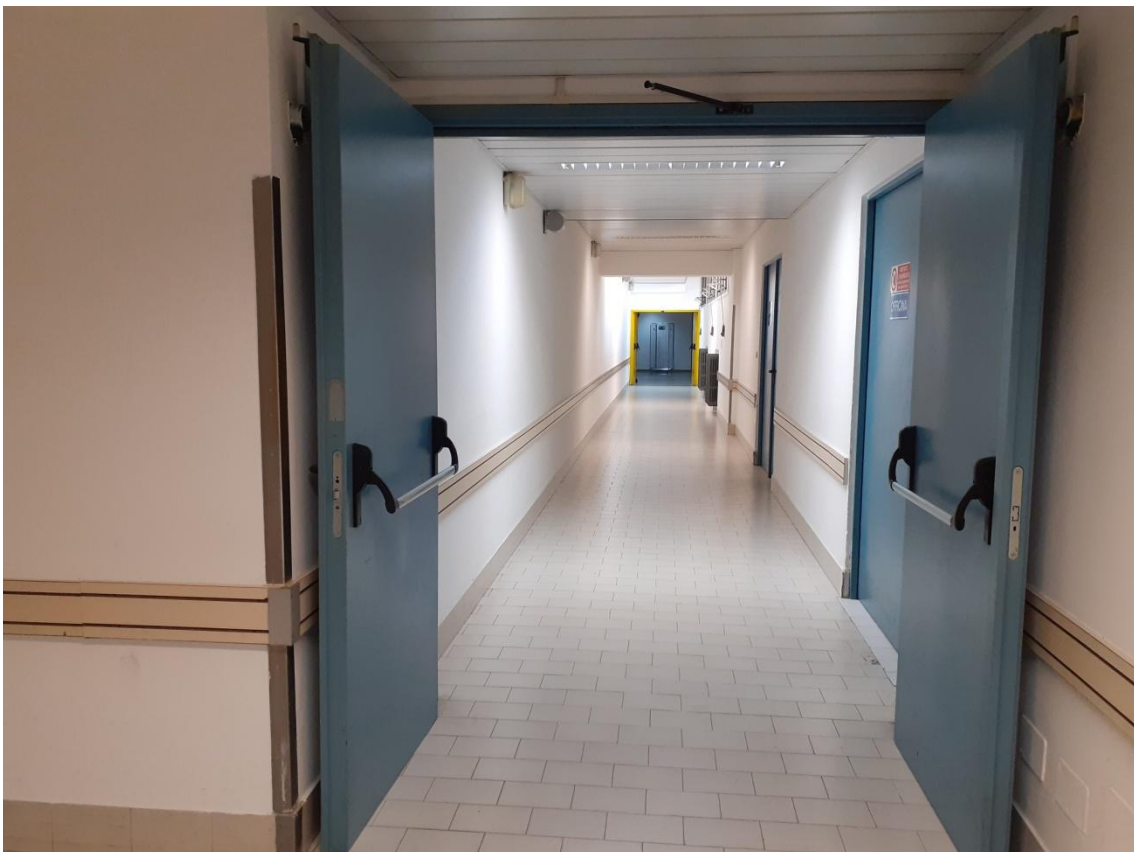
Foto 22 Piano seminterrato - collegamento
