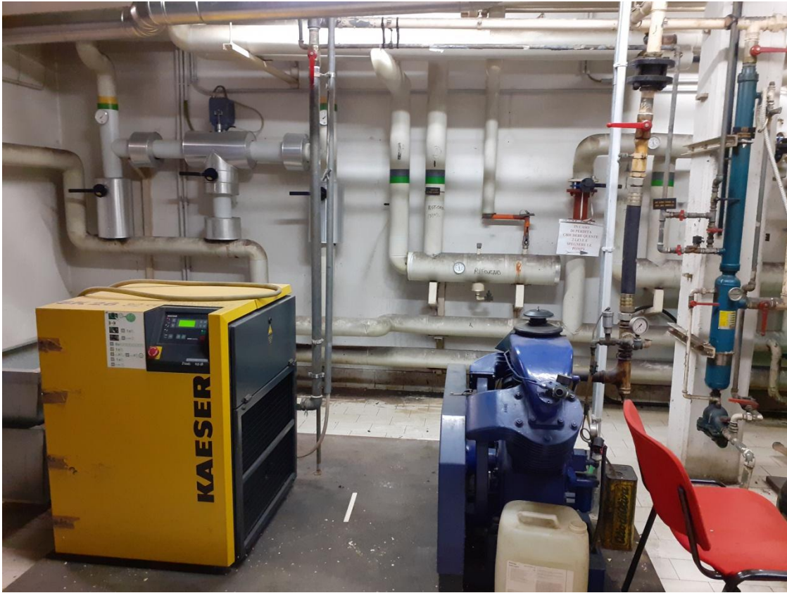
Foto 13 Piano seminterrato - locale tecnico
