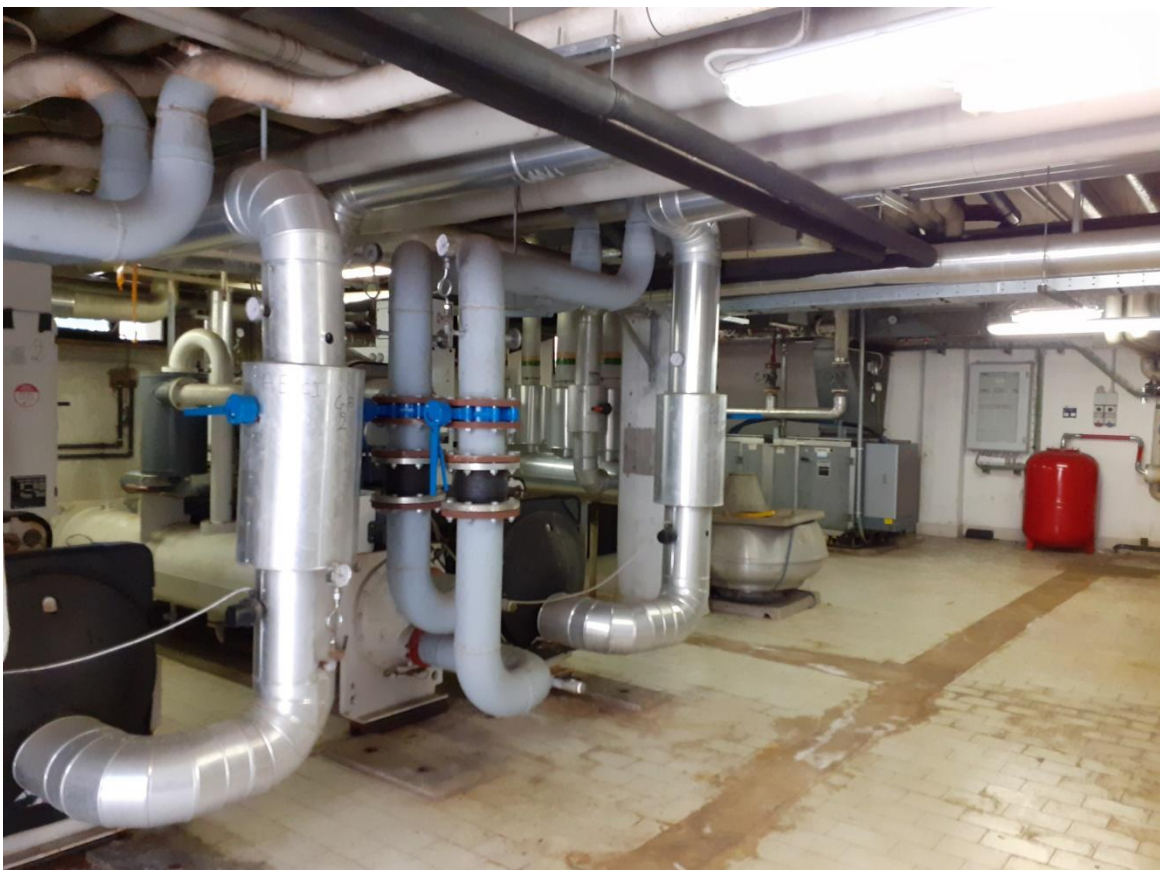
Foto 49 Locale tecnico - termoventilazione Residenza Rose
