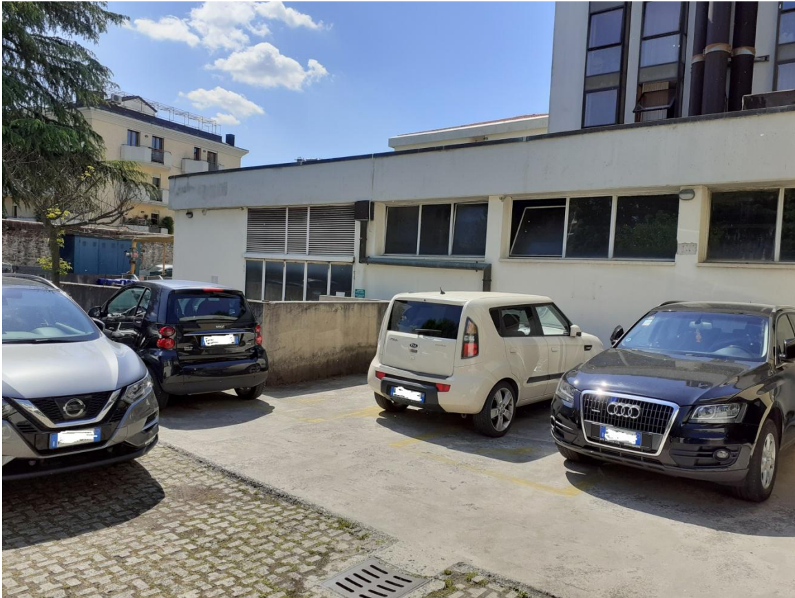
Foto 40 Vista centrale termica
