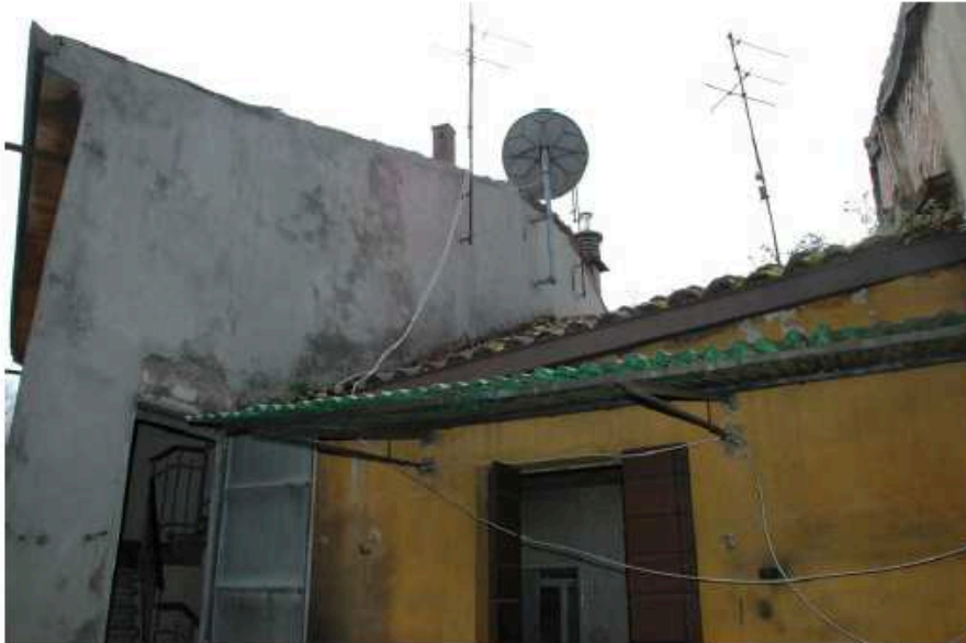
Foto 20 – Terrazza lato nord - Piano secondo
