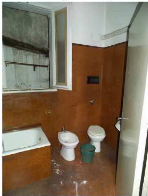
Foto 13 – Bagno – Piano primo
