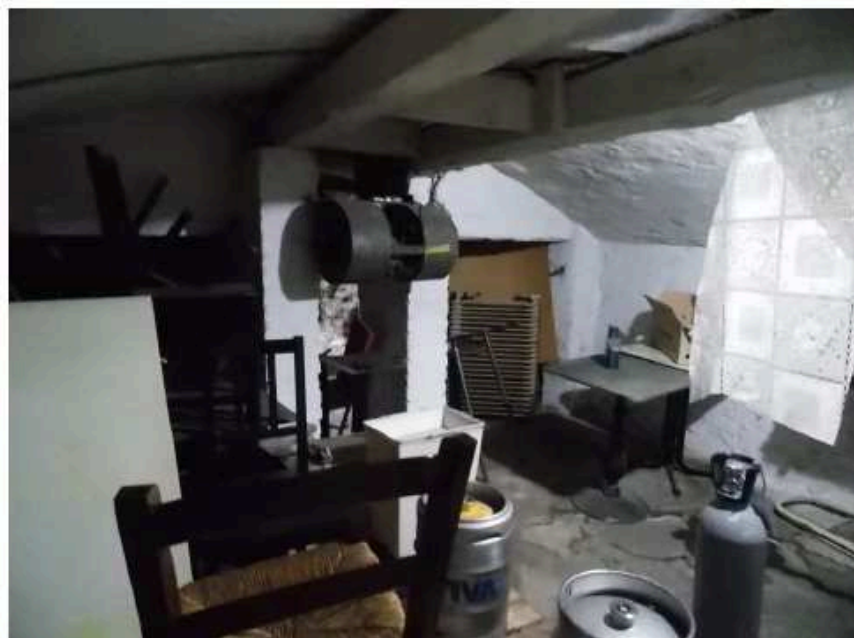
Foto 6 – Locale cucina – Piano primo sottostrada
