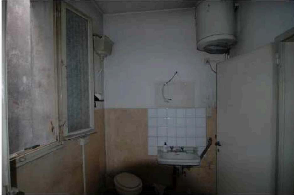
Foto 18 – Bagno - Piano secondo
