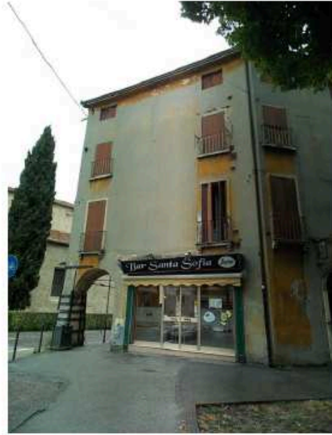
Foto 2 – Prospetto lato est su angolo tra via Altinate e via Morgagni
