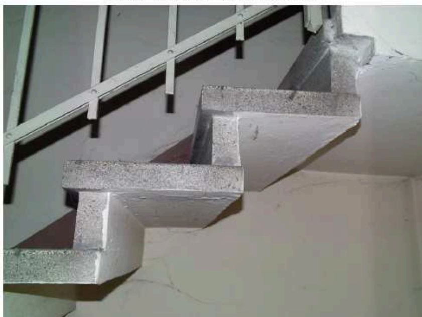
Foto 23 – Particolare sulla struttura della scala
