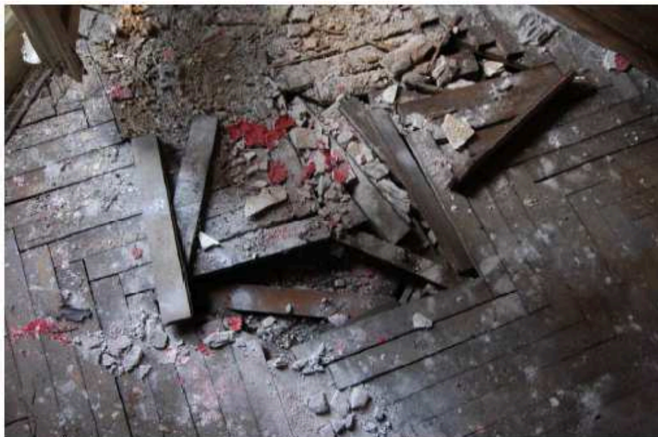
Foto 16 – Particolare degrado della pavimentazione camera - Piano secondo
