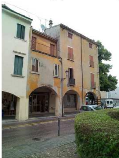
Foto 1 –Prospetto lato sud su via Altinate
