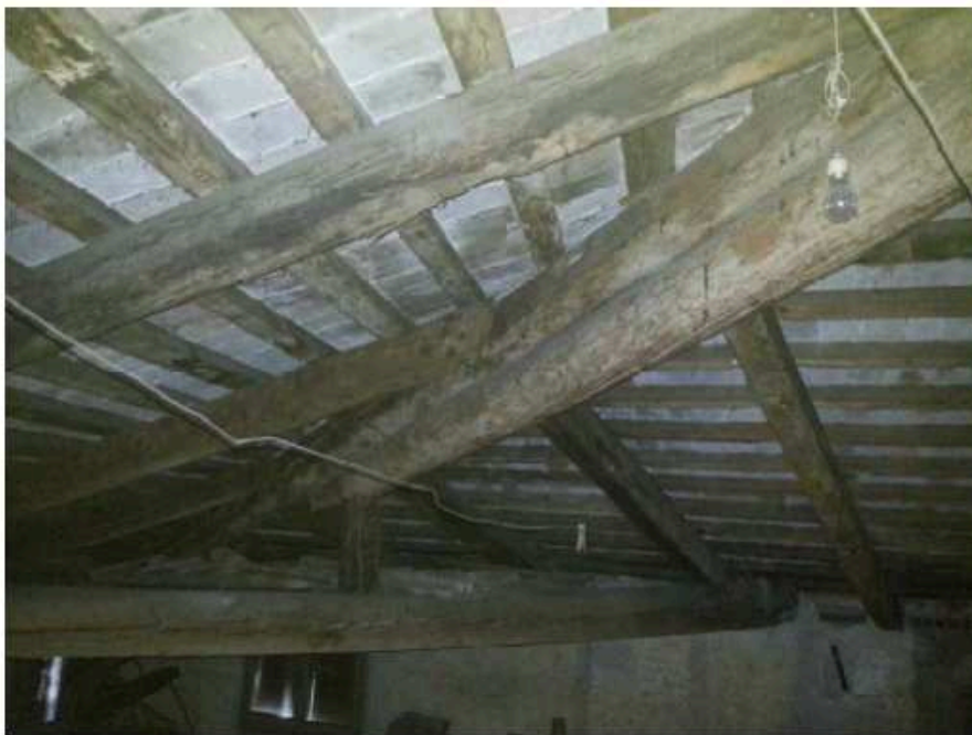
Foto 21 – Particolare travature – Piano terzo
