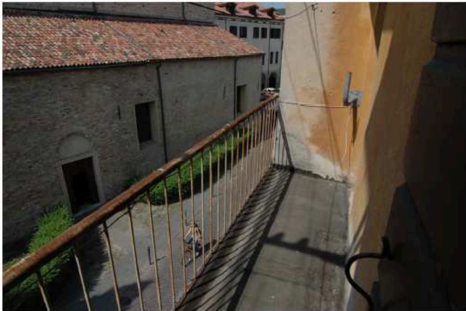
Foto 19 – Terrazza lato sud - Piano secondo
