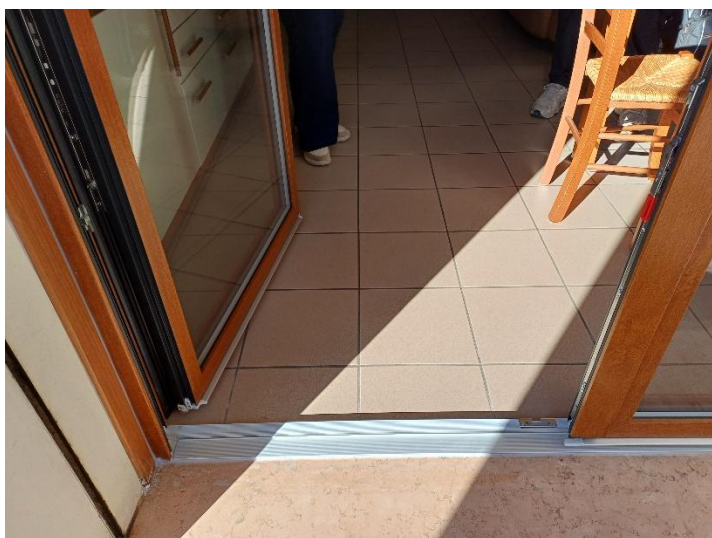
8. Fine lavori – dettaglio soglia accessibile
