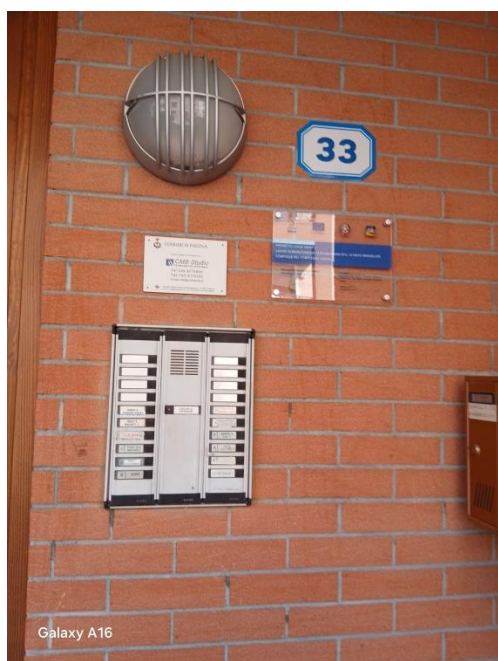
11. Fine lavori – targa installata all'ingresso del fabbricato
