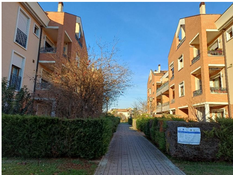
2. Area di intervento – cartello di cantiere
