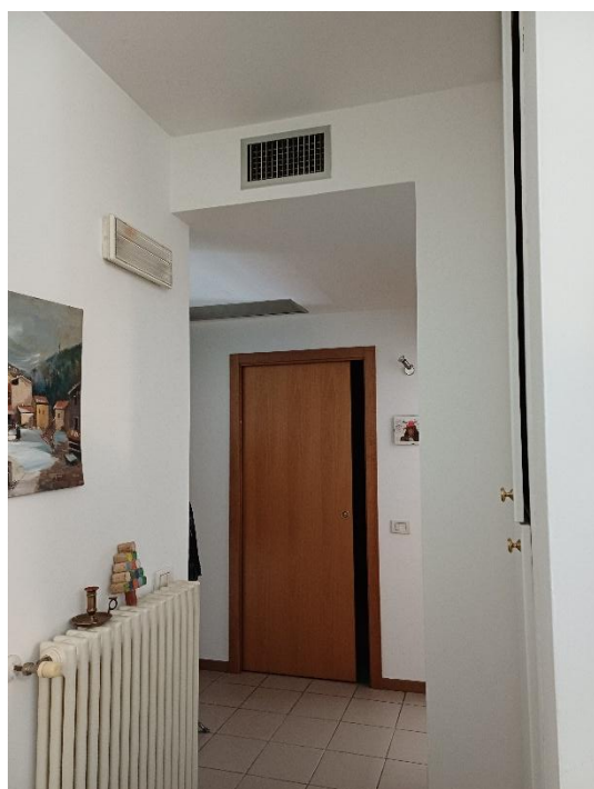
8. Fine lavori – impianto climatizzazione concluso
